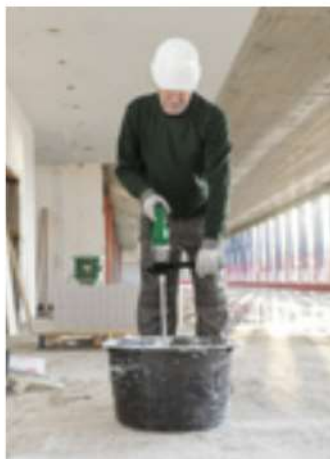
Das kabellose Rührwerk UM36DA arbeitet sich zuverlässig und fix durch flüssige Baumaterialien wie Farben, Lacke oder Mörtel. Bild: HiKOKI
