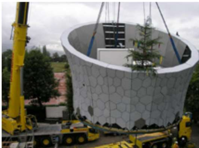
Der 19,8 Tonnen schwere «Hut» wurde als Sonderelement mit dem Kran in Position gebracht.
