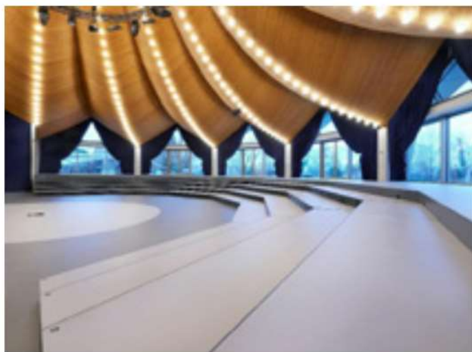
Blumer Lehmann fertigte 470 Akustikelemente für die Innenverkleidung des Zauberhutes.
