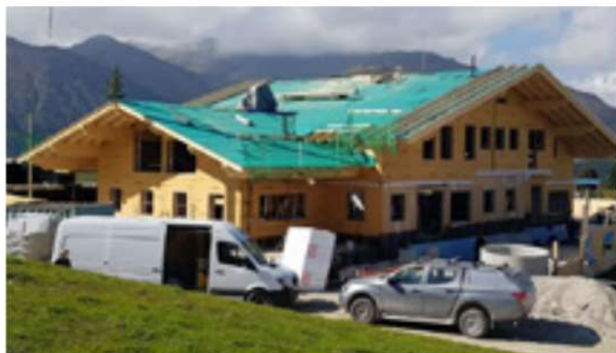
Beim Restaurant Kasermandl im Tirol wurde der neu entwickelte Thermosockel eingebaut.
