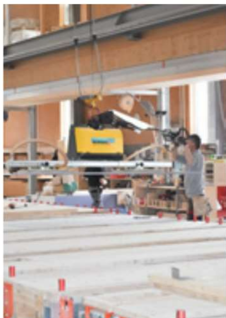
Platten werden per Vakuum platziert.
