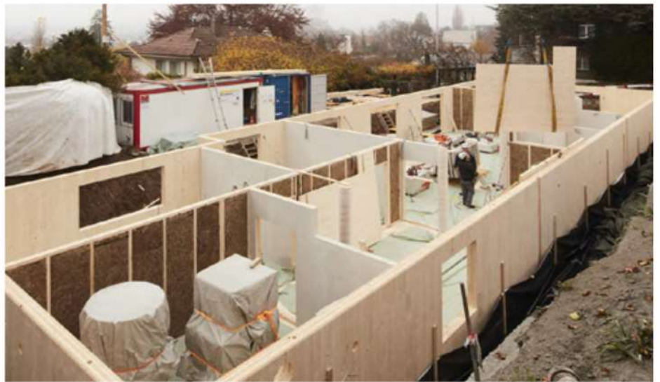
Der Keller entsteht aus Holzwänden.
