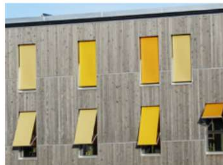
Gebäude mit Holzfassade.
