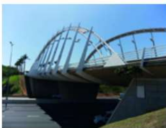
Die Planer der Moreland Millennium Bridge wählten für die tragenden Rundbögen Edelstahl Rostfrei der Güte 1.4301. Bild: WZV / Columbus
