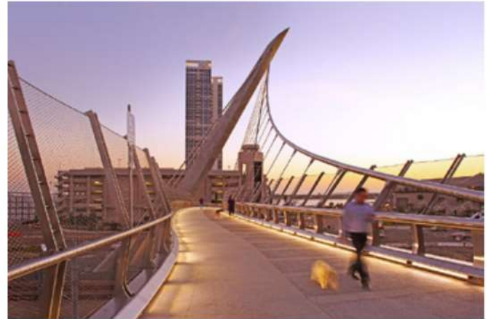
Für die Tragseile der Harbor-Drive Fussgängerbrücke in San Diego kam Edelstahl Rostfrei der Güte 1.4439 zum Einsatz, für den neben der jahrzehntelang gleichbleibend schönen Optik auch die Festigkeit sprach. Bild: TY Lin International / Safdie Rabines Architects
