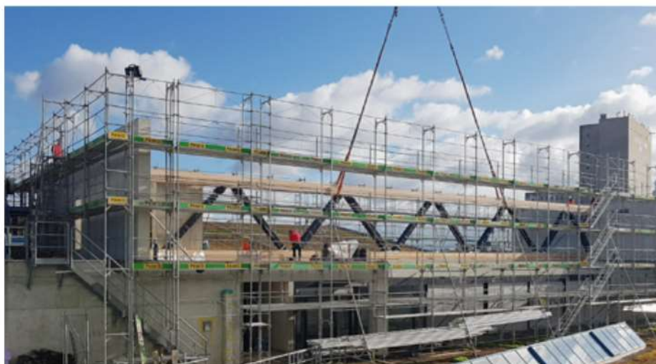
Auf den Millimeter genau wurde der vorgefertigte Fachwerkträger in die Betonaussparungen über dem bestehenden Bürogebäude eingefügt. Fotos: Fagus Suisse SA
