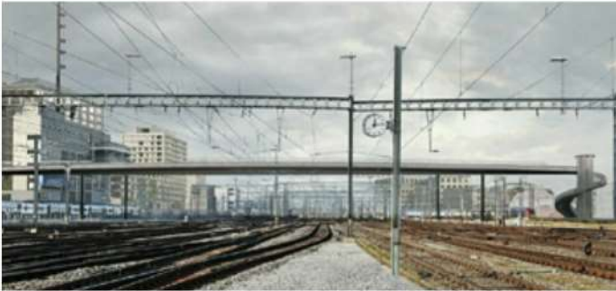
Der Negrellisteg überspannt als 160 Meter lange Stahlkonstruktion das Gleisfeld vor dem Zürcher Hauptbahnhof. Bild: SBB
