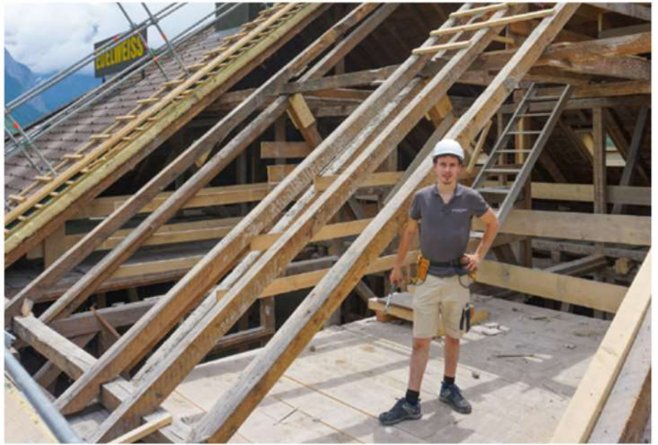
Anpacken beim Hotel Edelweiss in Engelberg. Fotos: Holzbau Schweiz
