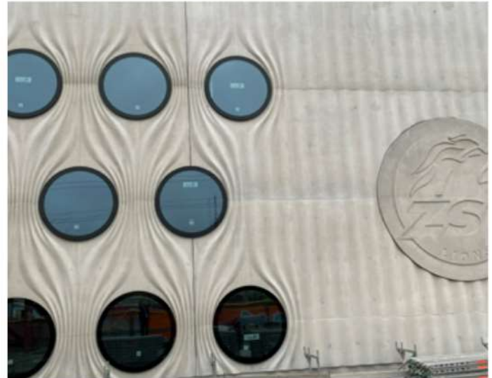
Die filigrane Ortbetonstruktur der Nord- und Südseite erzeugt den Eindruck eines textilen Faltenwurfs, der sich wie ein zurückgeschobener Vorhang um die kreisförmigen Fenster legt. Bild: Surber Metallbau
