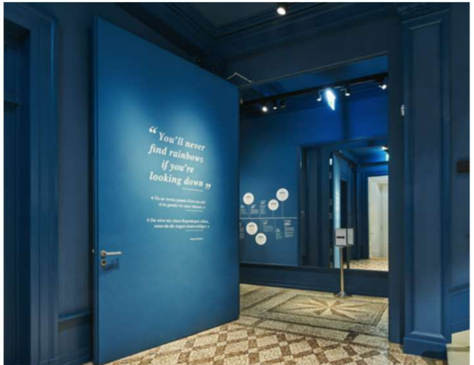
Brandschutz in neuer Dimension: 2.10 Meter hohe und 1.84 Meter breite Drehflügeltüren UniStar 68 sichern den Brandabschnitt. Fotos: RWD Schlatter AG
