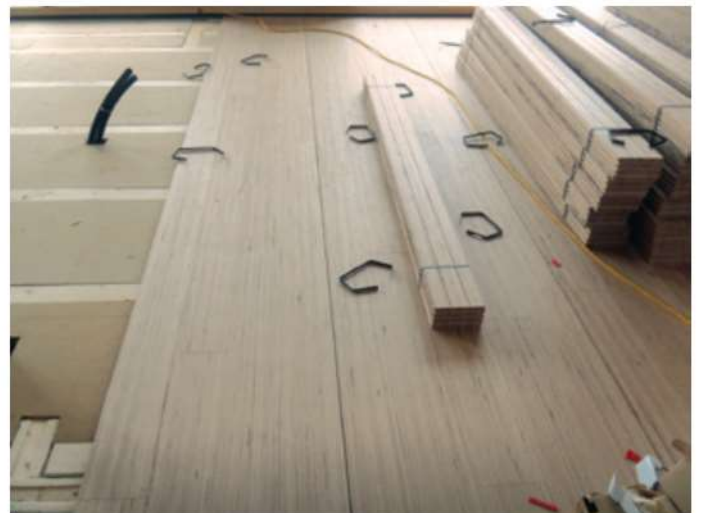
Verlegen der BauBuche.
