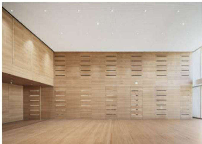
Aula – Boden und Wände aus BauBuche.
