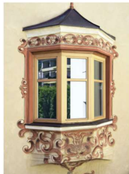
Nachgebautes historisches Fenster.
