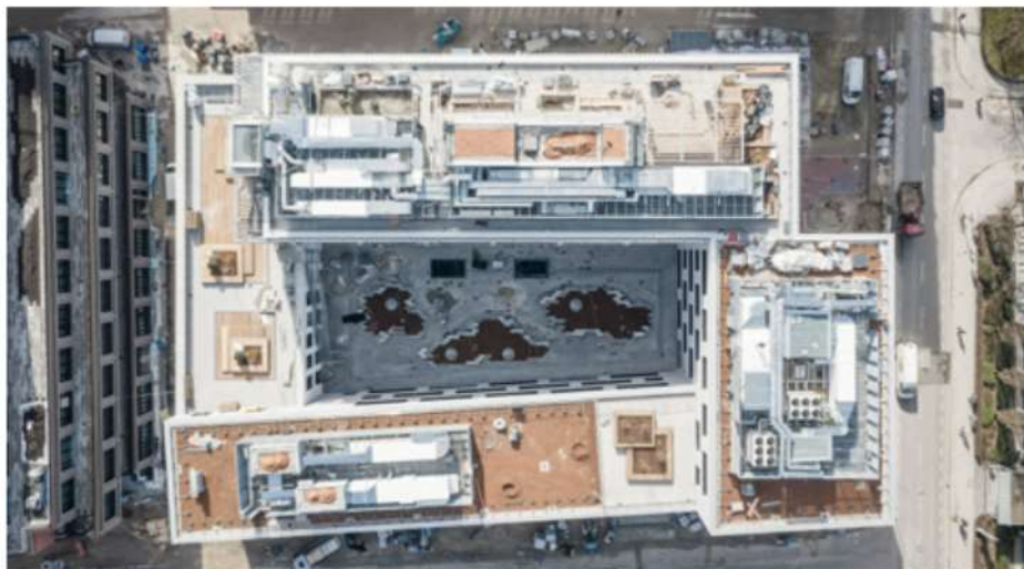
Baustelle der Macherie in München, ein Projekt der Accumulata Real Estate Group.
