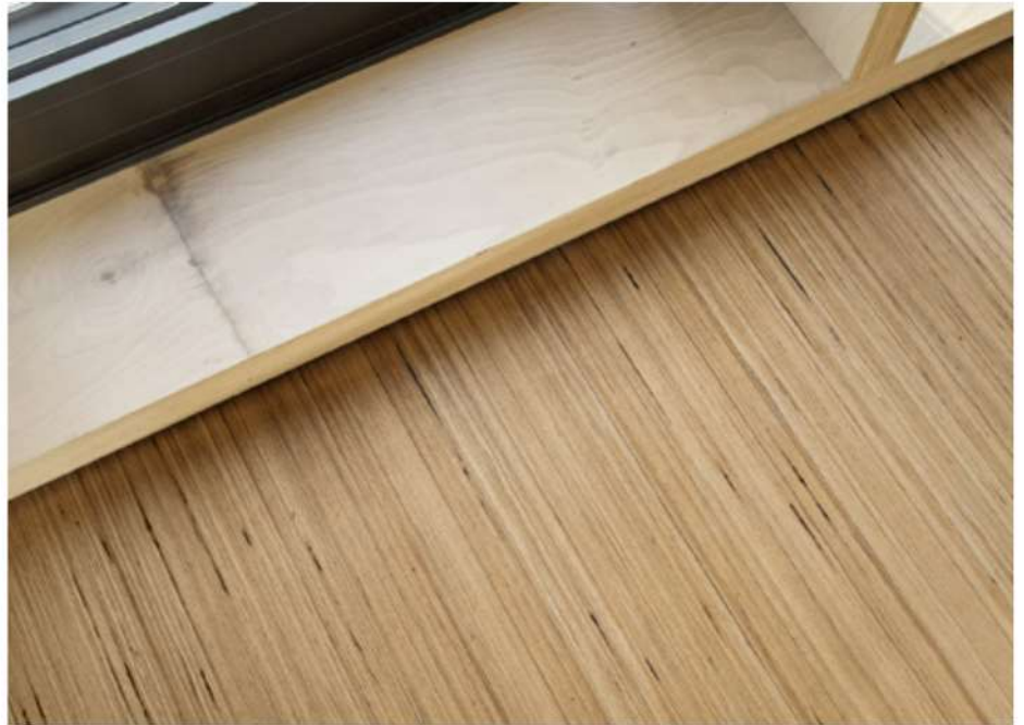
Übergang des Bodenbelages BauBuche zum Fenster.
