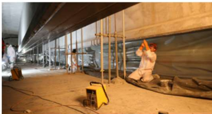
Sanierung einer der Autobahn-Brücken zwischen Küssnacht und Brunnen: Im Oktober 2018 wurden Betonträger erstmals mit CFK-Lamellen mit der Ebrog-Methode verstärkt; allerdings noch ohne Vorspannung. Bild: S&P Clever Reinforcement Company AG
