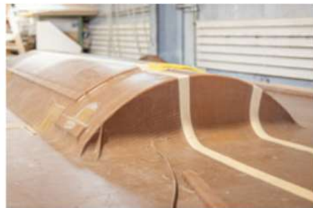
Die Vakuumverleimung während des Pressvorganges.
