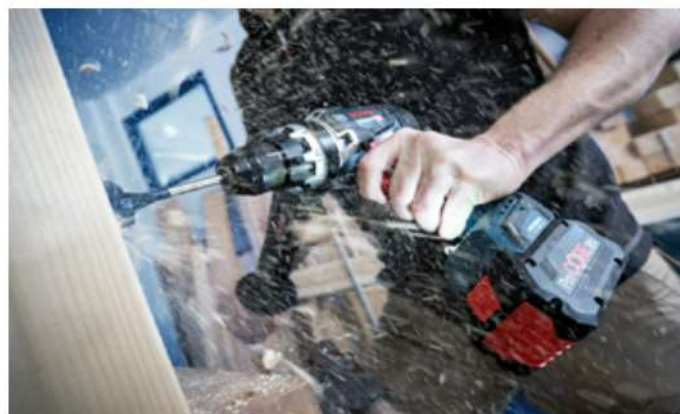
Verschiedene Gewerke auf einer virtuellen Baustelle in 1,5 Stunden erleben.
