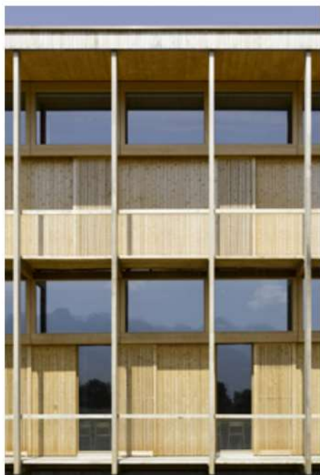
Silber – Landwirtschaftliches Zentrum St. Gallen in Salez, Südfassade.
