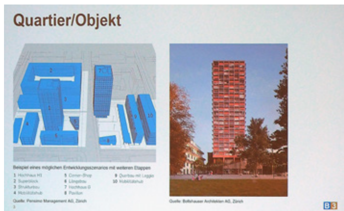
In Regensdorf ZH entsteht ein 75 Meter hoher Holz/Beton-Hybridbau. Visualisierung: Boltshauer Architekten AG, Zürich
