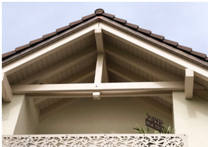
Dachunterseite mit ADLER Pigmolux-Oberflächenschutz.
