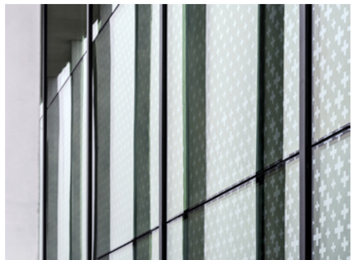
Von innen stört der Druck die Durchsicht nicht und wirkt zudem als Sonnenschutz.
