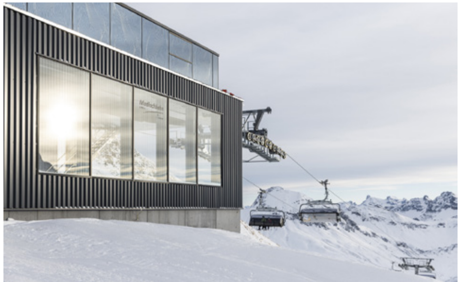
Gläser mit integriertem Vogelschutz an der Bergstation der Madlochbahn in Zürs am Arlberg, Österreich.
