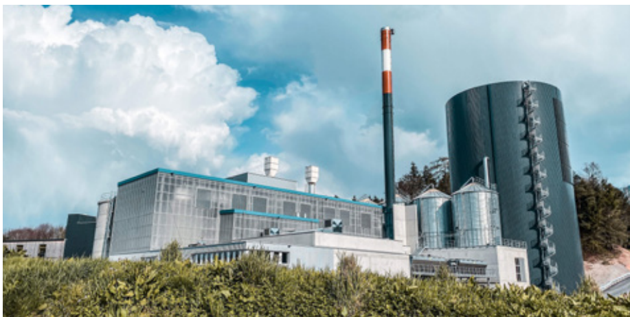
Holzheizkraftwerk der ECOGEN Rigi Genossenschaft in Haltikon (SZ) wird mit Restholz, Altholz und Waldhackschnitzeln betrieben. Die Ende 2020 eröffnete Anlage liefert Strom für 8000 Haushalte (32 GWh/a) und Wärme für 6000 Haushalte (64 GWh/a). Rechts im Bild: der 45 m hohe Wärmespeicher mit einer Kapazität von 850 MWh. Foto: ECOGEN Rigi Genossenschaft
