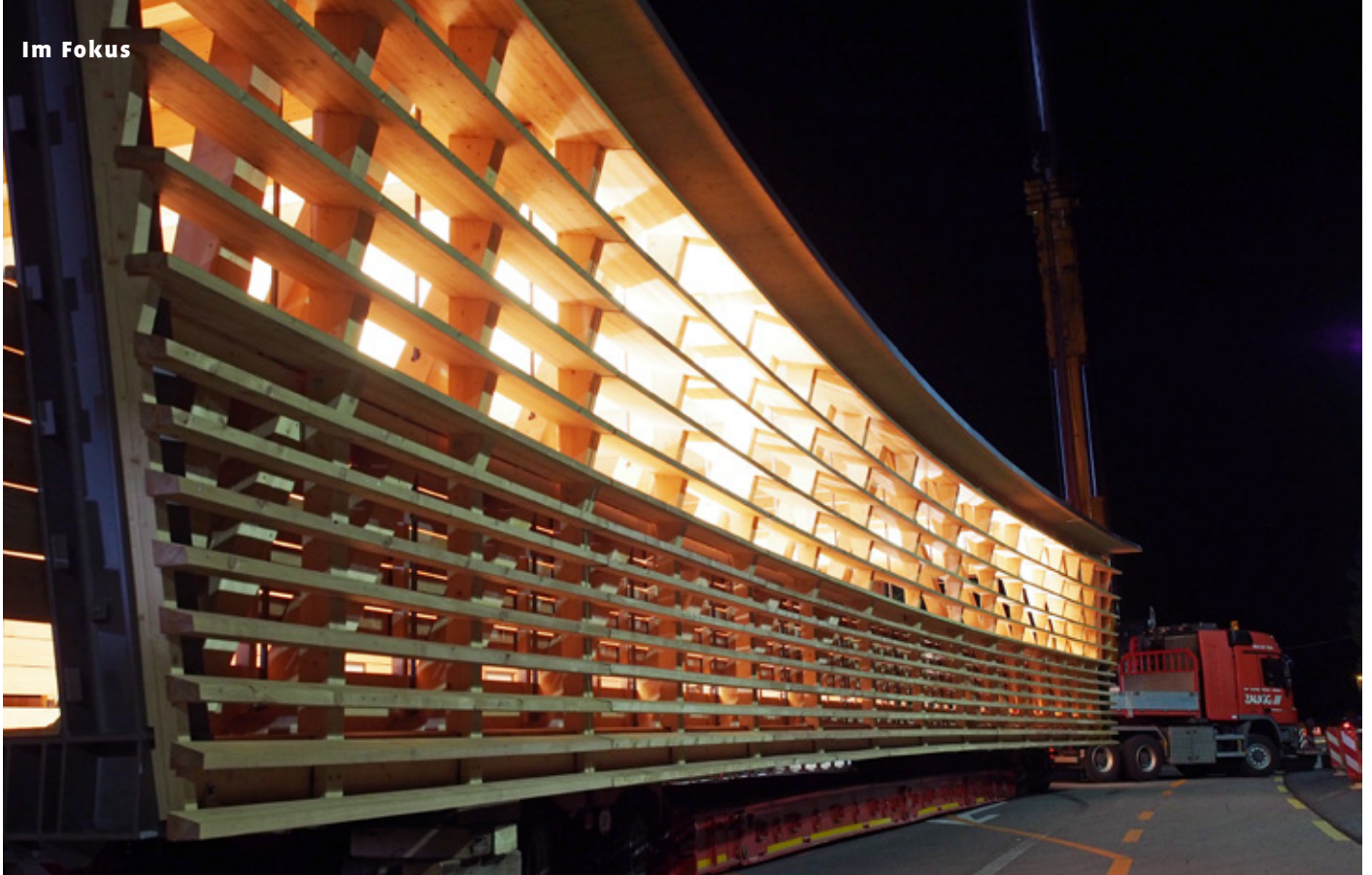
Der aufstrebende Schweizer Holzbau könnte noch vermehrt im Finanzmarkt wahrgenommen werden und dieser ihm neue Impulse verleihen. Bild: Warten auf die Montage – 30 Tonnen schwere Holzbrücke über die Autobahn bei Rubigen BE. Foto: Martin Binkert
