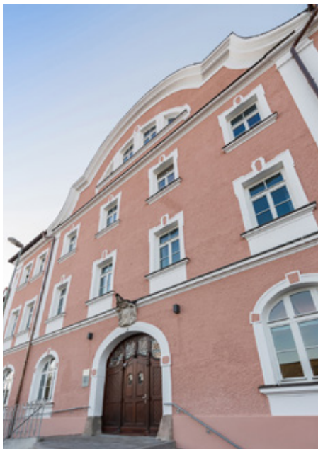
Das ehemalige Spital in Passau aus dem 11. Jahrhundert wird seit 2020 als Pflegeschule genutzt.
