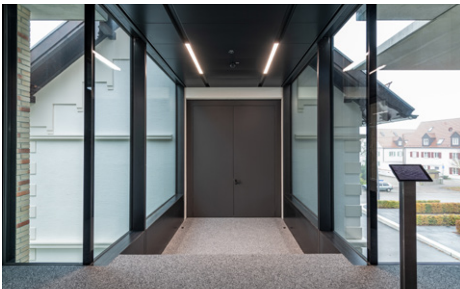
Doppelflügelige Eingangstür ins Stammhaus mit einer Höhe von 3,4 Metern.
