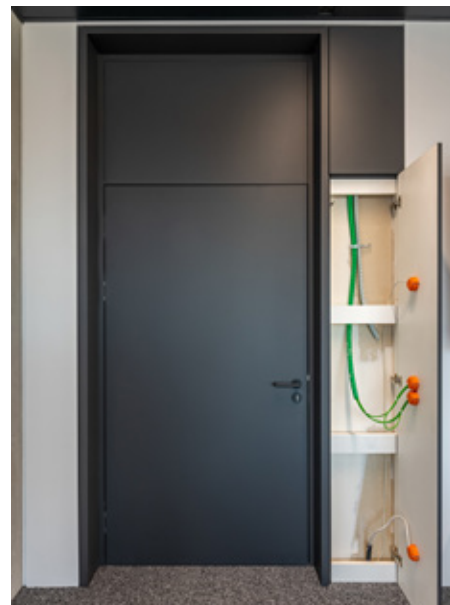
Raumhohe Elemente aus Tür und Oberblende mit Inspektionstüren für die Technik.
