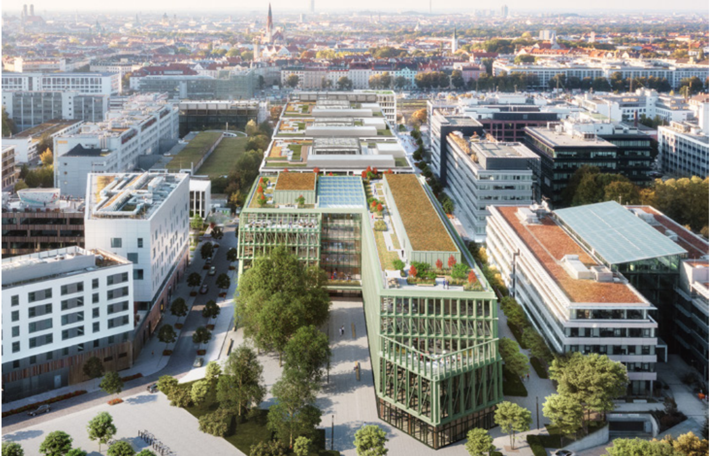
Mit seiner markanten Form- und Farbgebung eröffnet das i8 auf dem iCampus im Werksviertel das neue Work-Life-Quartier von der Rückseite.
