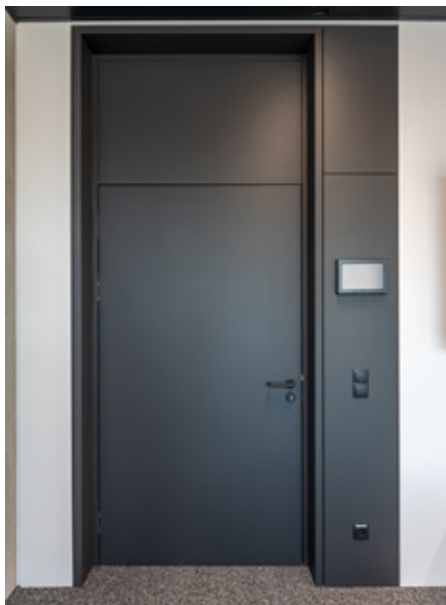
Raumhohe Elemente aus Tür und Oberblende mit Inspektionstüren für die Technik.
