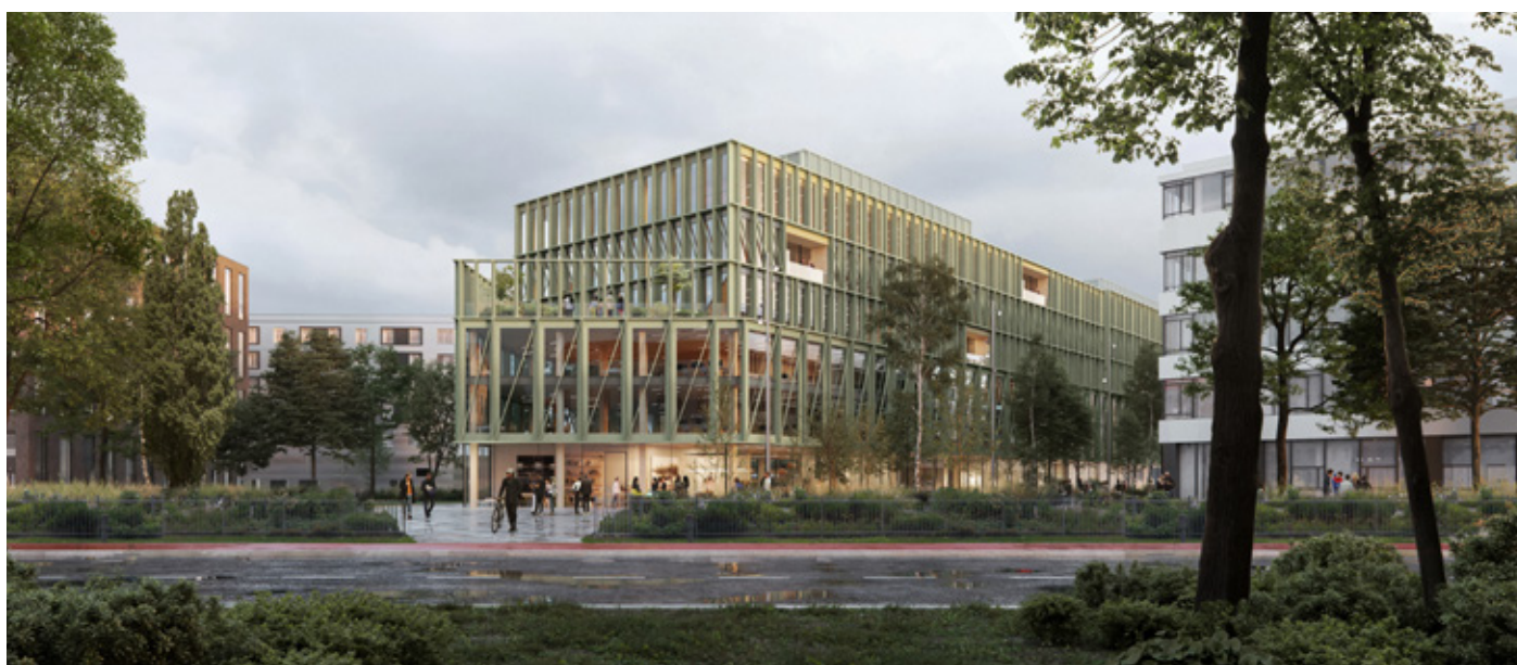
Innen Holz, aussen Grün: Die Fassade aus recyceltem Aluminium sowie die unauffällig ins Dach integrierte Photovoltaikanlagen des i8 sind in beruhigendem Grün gehalten. Bilder: R&S Immobilienmanagement GmbH
