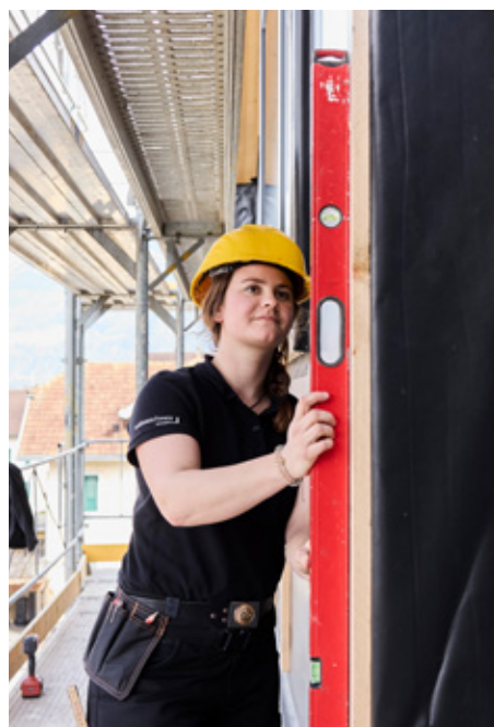
Lara Zwiefelhofer arbeitet auf einem Gerüst.
