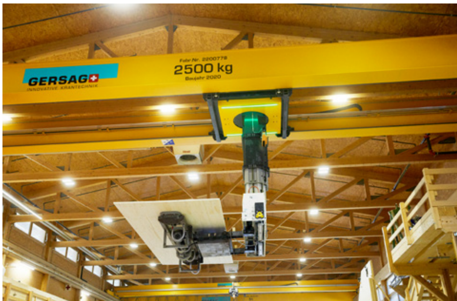
Mit Simi nutzt Brawand ihre verfügbaren Betriebsfläche optimal.
