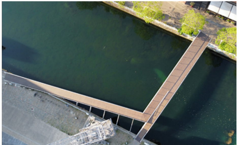
Aufgrund seiner Eigenschaften wurde Bambus als Bodenbelag für diese Fussgängerbrücke in Strassburg, Frankreich, gewählt. Fotos: Moso
