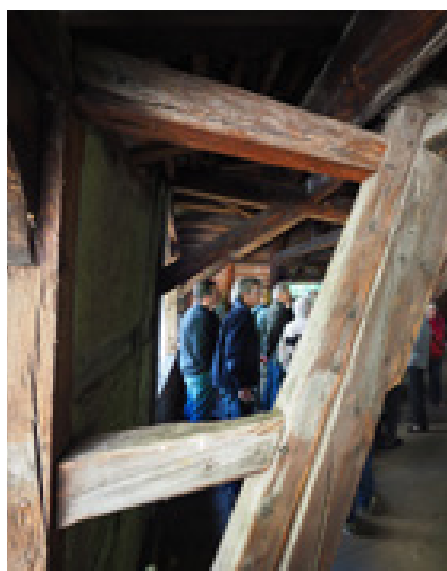
Besuch auf dem Dachstock.
