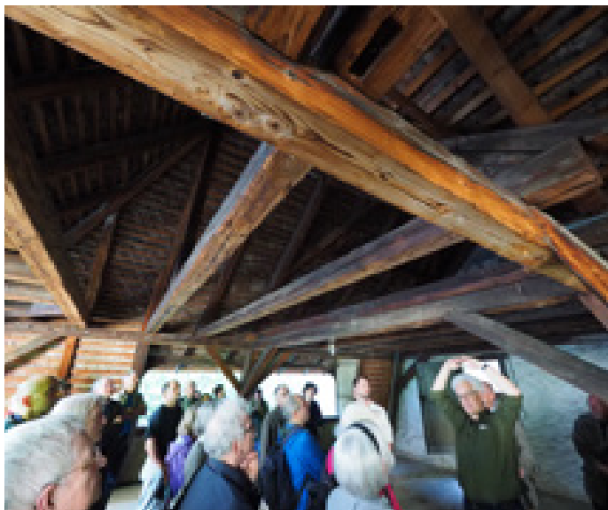
Blick in die Dachkonstruktion des früheren Färberhauses.
