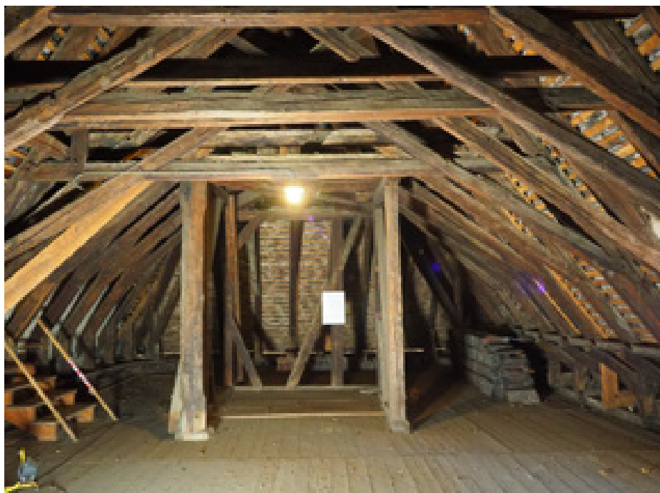
Mit dieser Holzkonstruktion («Bock») wurde der Dachstuhl stabilisiert.
