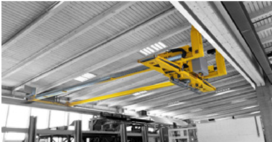
D-SA 500kg bei der Firma Holz-Abbund AG Wangen bei Dübendorf (ehemals Flück AG).
