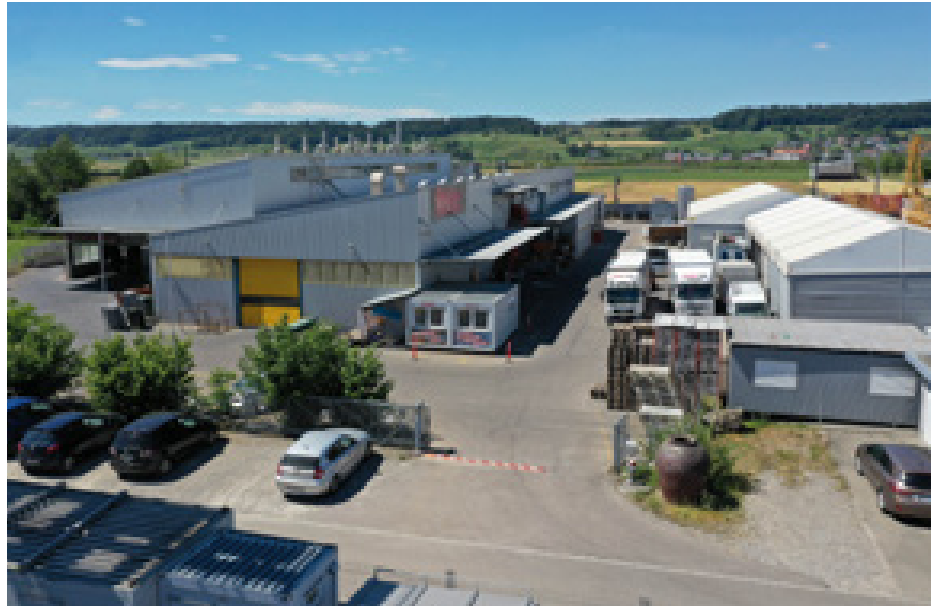
Firmengebäude der Meier Oberflächen AG – Marktleader in den Bereichen Ablaugen, Entlacken und Entrosten.
