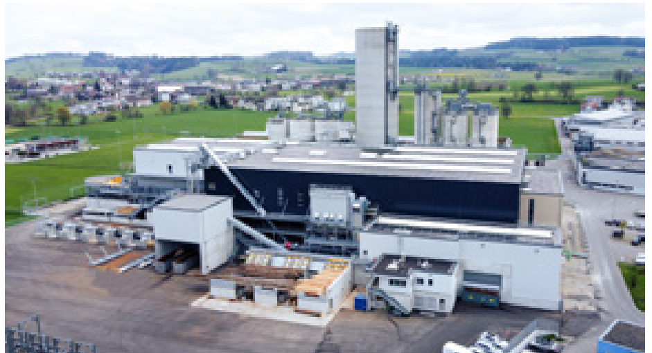
Der Neubau der Tschopp AG: Vecoplan lieferte Anlagen, um die Resthölzer der Sägewerkslinie zu entsorgen und aufzubereiten. Fotos: Vecoplan® AG
