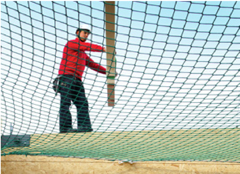
Auffangnetze bieten eine Möglichkeit Mitarbeitende vor Abstürzen zu bewahren. Bild: Suva
