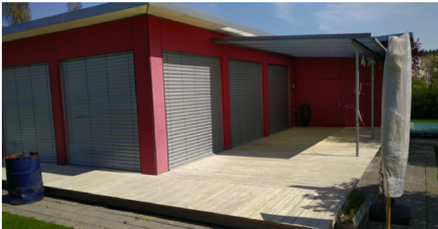
Die Accoya-Holzriemen auf der Terrasse erwiesen sich bei Regen, Nässe und Kälte als gefährliche Rutschbahn.
