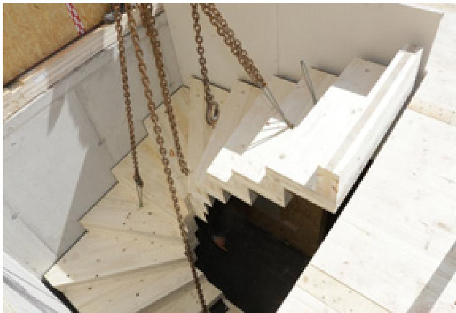
Falwerk-Treppe aus Brettsperrholz, Einheben in den Bau per Kran. Fotos: FHS Treppen GmbH
