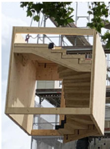
Einheben des kompletten Treppen-Moduls aus Brettsperrholz, inklusive Wänden für das Treppenhaus, hier zur Sanierung im Altbau.
