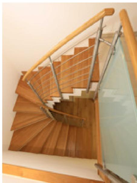
Die gleiche Falwerk-Treppe, nach Fertigstellung mit Edelstahl-Reling-Geländer, Stufen und Handlauf in Eiche.
