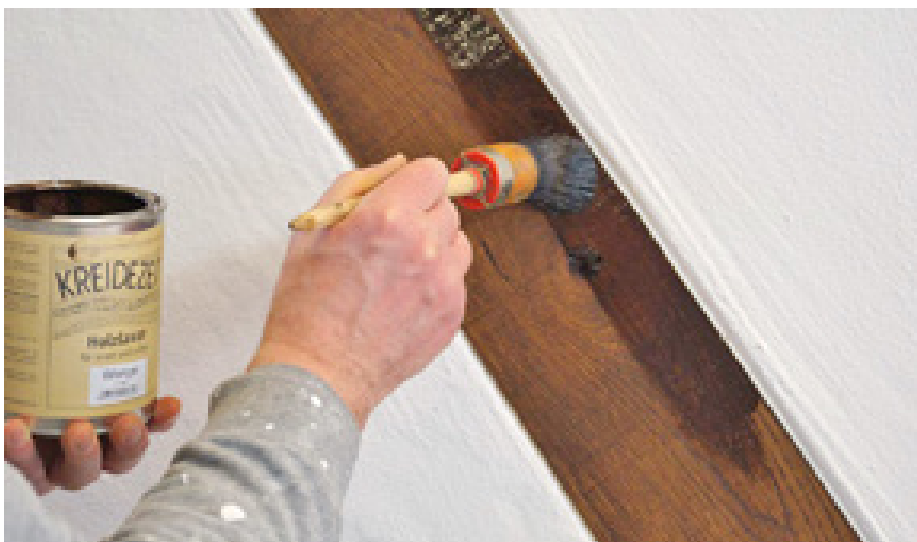
Die Lasuren eignen sich auch für die Behandlung von Fachwerk. Sie bestehen aus biologisch unbedenklichen Stoffen wie Lein- und Standölen und sind frei von Bioziden.
