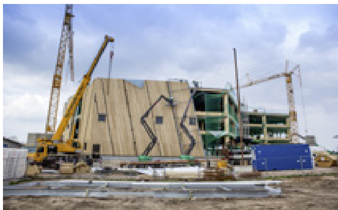
Montage Wandteil Boulderhalle Frankenjura. Bild: Rudolf Hörmann GmbH & Co. KG
