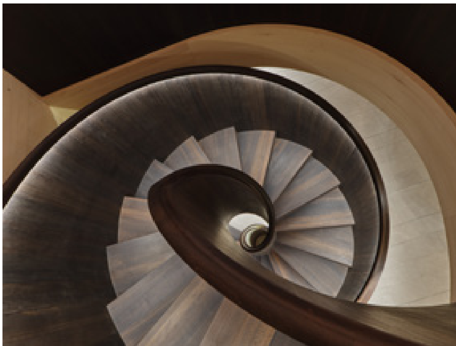
Kreisbogentreppe in Räumerei mit beidseitiger Brüstung und integrierter Handlaufbeleuchtung. (Haus des Holzes, Sursee | Ein Entwicklungs- und Vorzeigeprojekt für digitales, klimagerechtes und kreislauffähiges Planen und Bauen | Fotografie: MARCOLEU)
