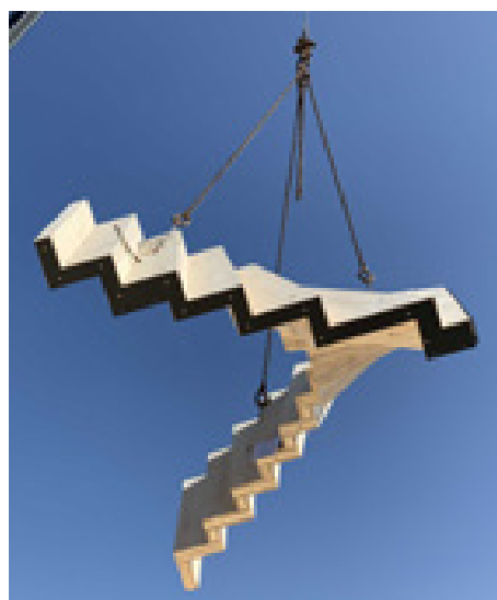
Faltwerk-treppe aus Brettsperrholz wird mit dem Kran eingehoben.
