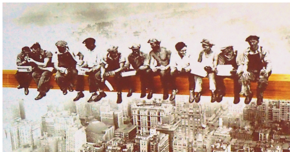
Dieses Bild kommt manchen bekannt vor. Doch im Original sitzen die Arbeiter auf einem Stahlträger und nicht auf einem Holzbalken.
