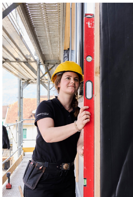
Lara Zwiefelhofer arbeitet auf einem Gerüst.
